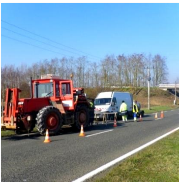
Réalisation de sondages sur des voies publiques
