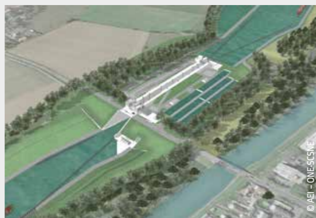
Vue aérienne de l'écluse de Noyon
