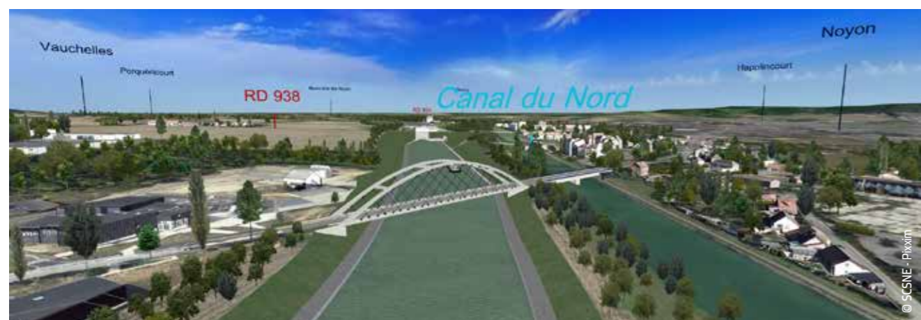
Vue du Canal Seine-Nord Europe (vers le Nord) et du nouveau pont à l'entrée de Noyon
