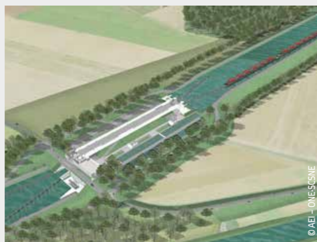
L'écluse de Catigny
