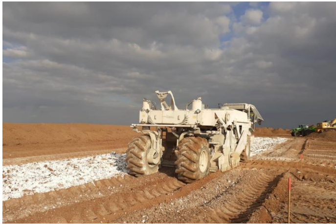
Traitement des sols. Source SCSNE Secteur 4
