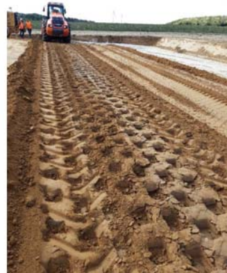
Travaux sur les planches d'essais d'étanchéité
