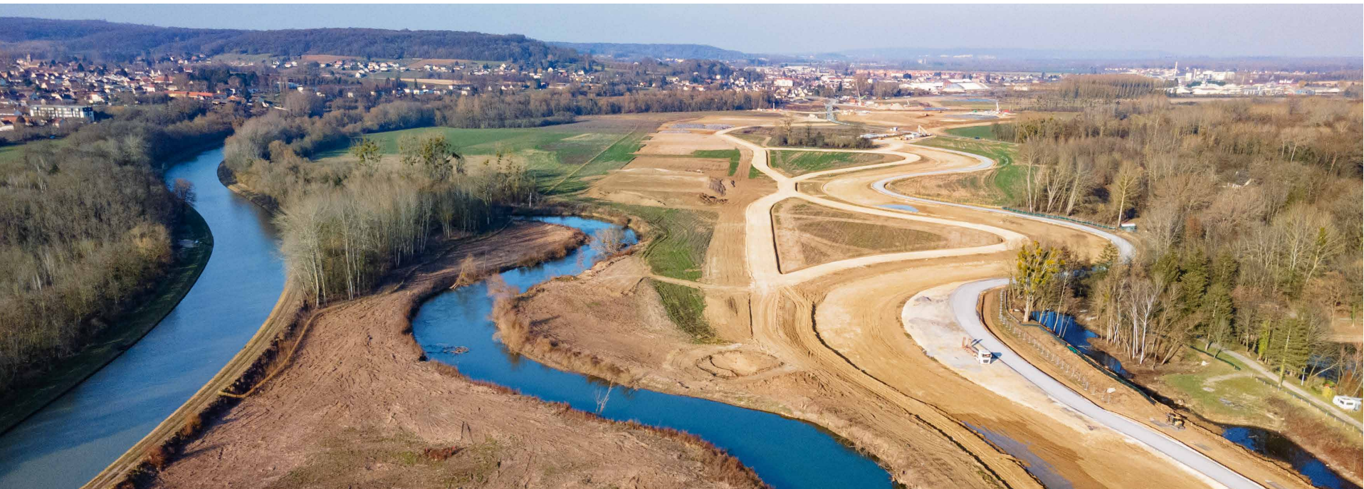
Vue d'ensemble des sites en chantier, début mars 2023 © SCSNE / J.-C. Hecquet
