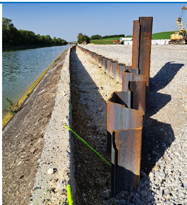
Rideau principal de palplanches à Allaines - ©SCSNE
