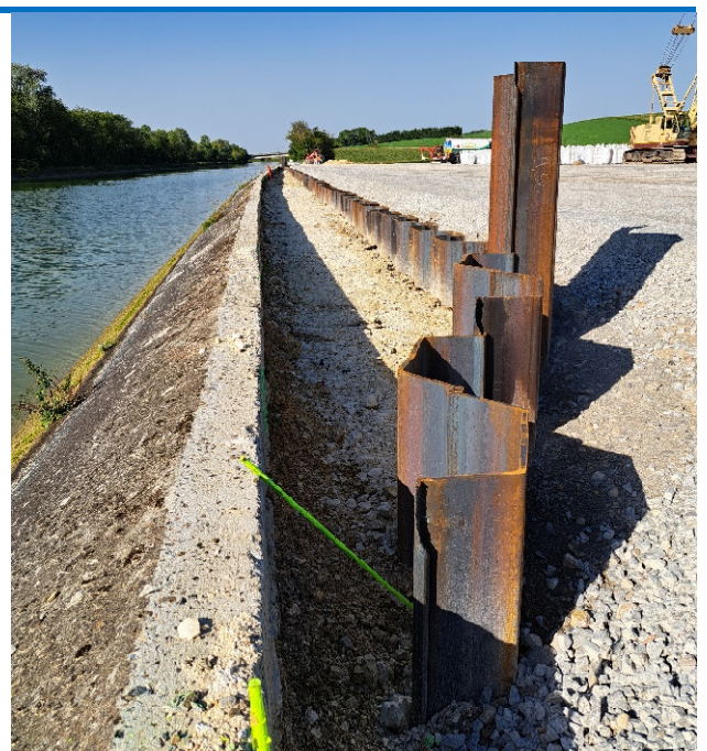
Rideau principal de palplanches à Allaines - ©SCSNE
