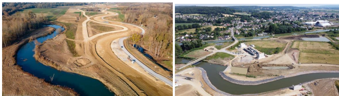
Figure 24 : vues aérienne travaux du rescindement de l'Oise et construction des nouveaux ponts
