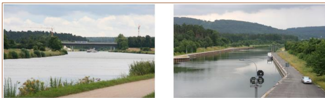
Exemples de canaux à grand gabarit (canal Main/Danube, Allemagne)
