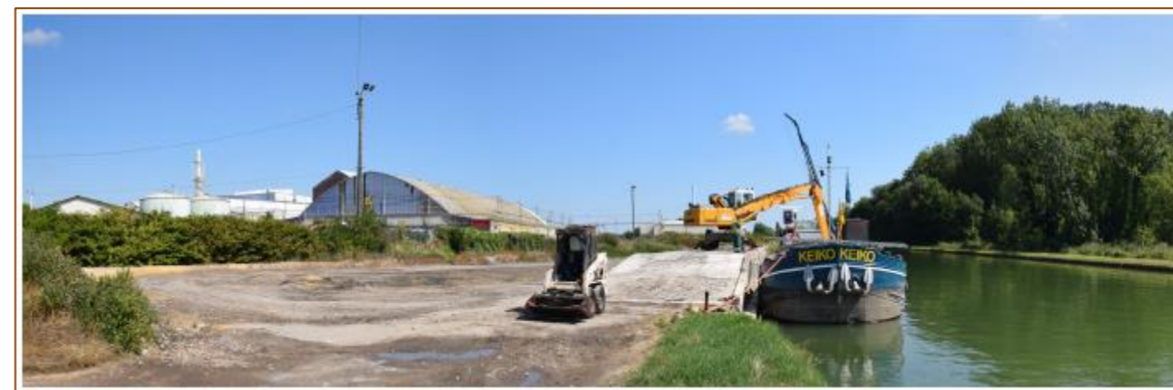
Illustration 2 : Exemple d'un quai de transbordement à Thourotte sur le canal latéral à l'Oise (Source : Schéma d'orientations architecturales et paysagères du CSNE, 2016)
