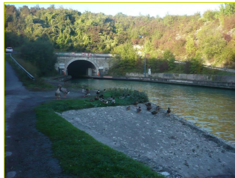
Photo 2 : Entrée sud du tunnel de Ruyaulcourt
