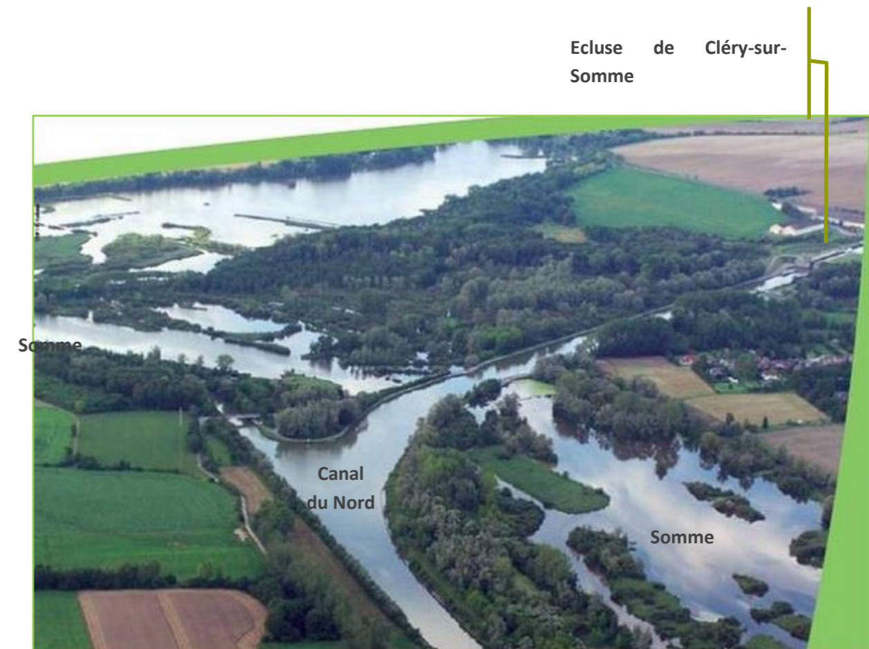
Photo 3 : Passage en siphon de la Somme sous le canal du Nord dans le secteur de Cléry-sur-Somme
