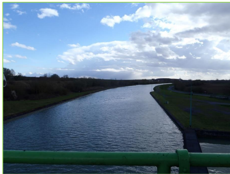
Photo 9 : Ecluse 8 de Moislains. Vue vers le Sud du canal du Nord, destiné à être localement comblé
