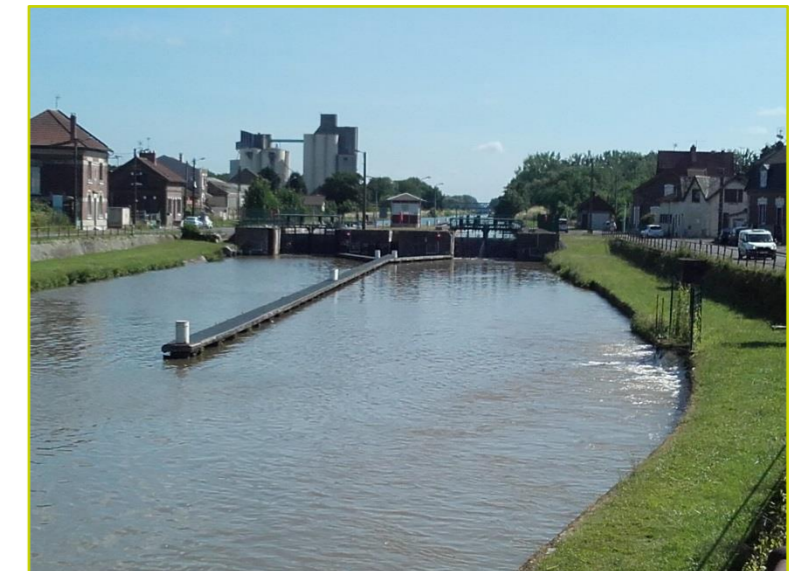
Photo 1 : Vue sur le canal latéral à l'Oise près de l'écluse de Chauny
