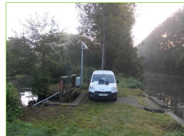
Photo 5 : Prise d'eau de Dury
