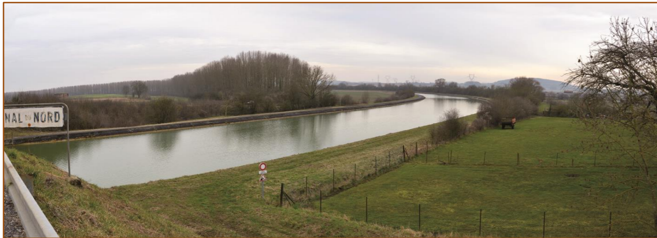
Photo 8 : Dérivation du canal du Nord. Vue du pont de Catigny
