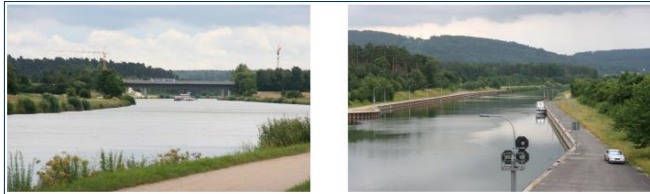
Illustration 1 : Exemples de canaux à grand gabarit (canal Main/Danube, Allemagne)
