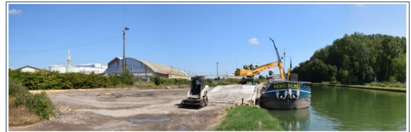
Illustration 2 : Exemple d'un quai de transbordement à Thourotte sur le canal latéral à l'Oise
