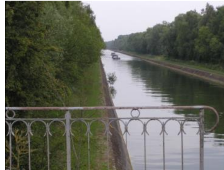
Photo 3 : Le Canal du Nord (source : setec 2006)
