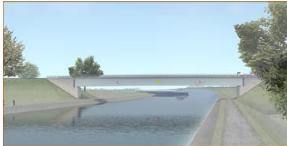
Figure 10 - Ouvrages de type Bipoutre (source : ONE 2021)
