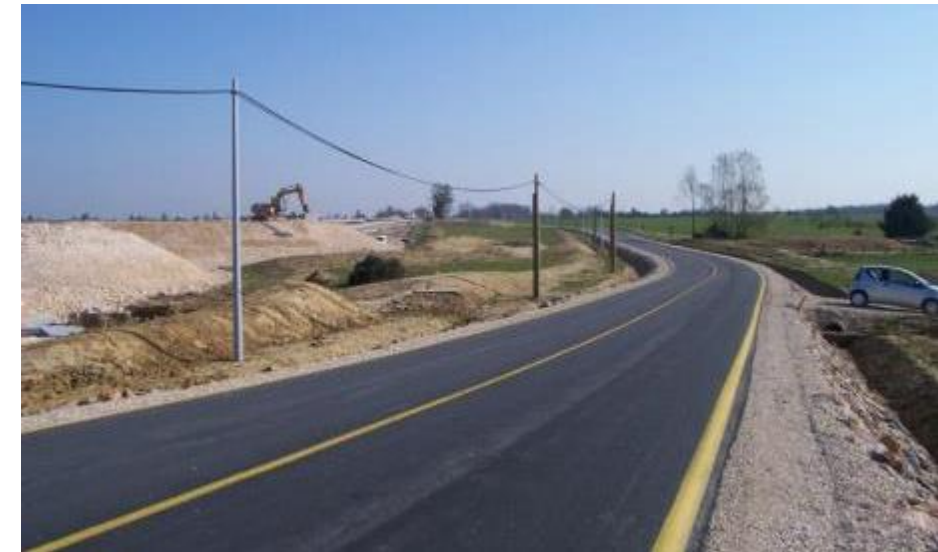
Photo 4 : Mise en place dérivation de route (Source : chantier LGV Rhin-Rhône, setec)
