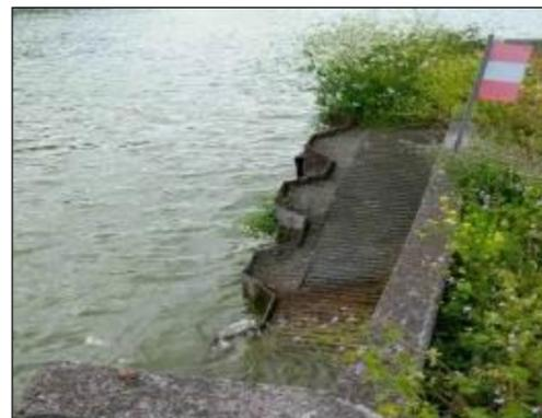
Photo 24 : Echelle anti-noyade pour la faune sur le canal du Nord (Source Setec)
