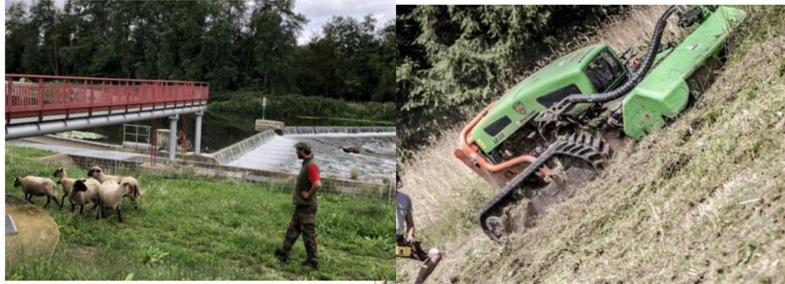
Figure 125 : Exemples d'entretien pour le talus supérieur de la tranchée
