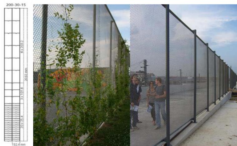
Figure 50 : Schéma de principe et exemple de clôture avec maille métallique spiralée
