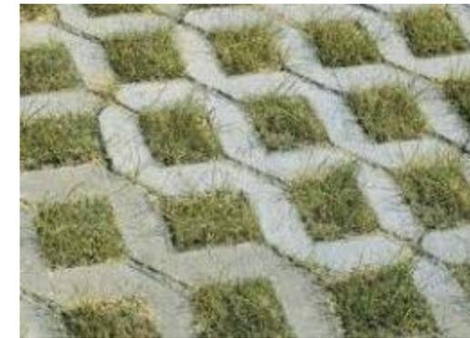
Figure 61 : Exemple de revêtement proposé pour le chemin de service au droit des sorties d'eau : structure alvéolaire en béton
