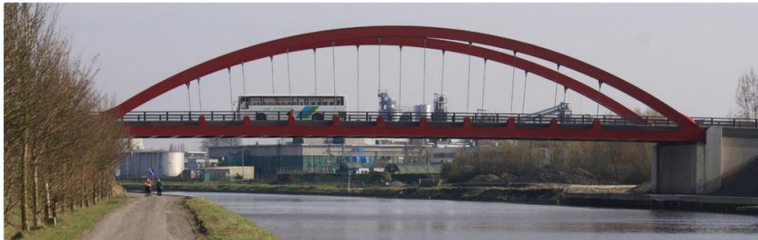
Figure 102 : Canal de Dunkerque-Escaut à Essars - Structure en bow string
