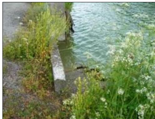
Photo 23 : Echelle anti-noyade pour la faune sur le canal du Nord (Source Setec)
