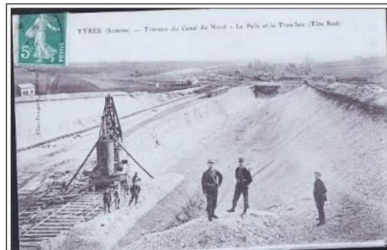
Creusement du canal côté Ruyaulcourt en 1914 (machine vapeur)
