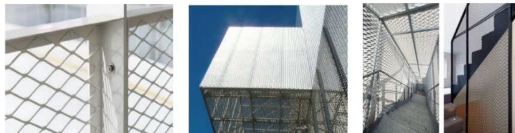
Figure 104 : Métal déployé pour le traitement des émergences des écluses, les escaliers, garde-corps et ascenseurs
