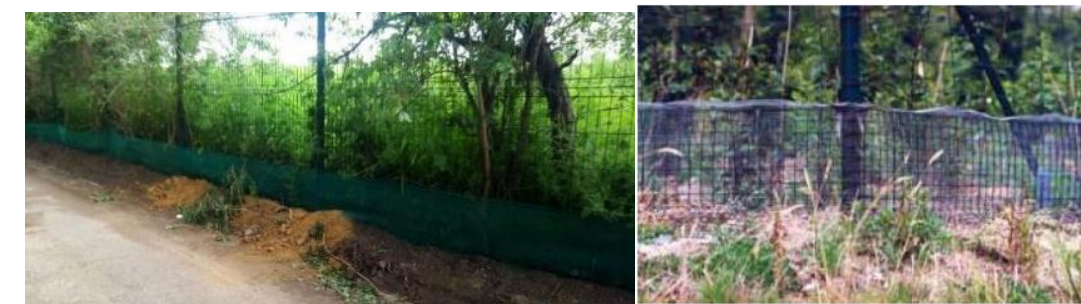
Treillis soudé à mailles fines adossé à une clôture à grandes mailles, avec la partie supérieure recourbée et la partie inférieure enterrée – Source : Biotopie à gauche et J. Carsignol, SETRA 2008 à droite
