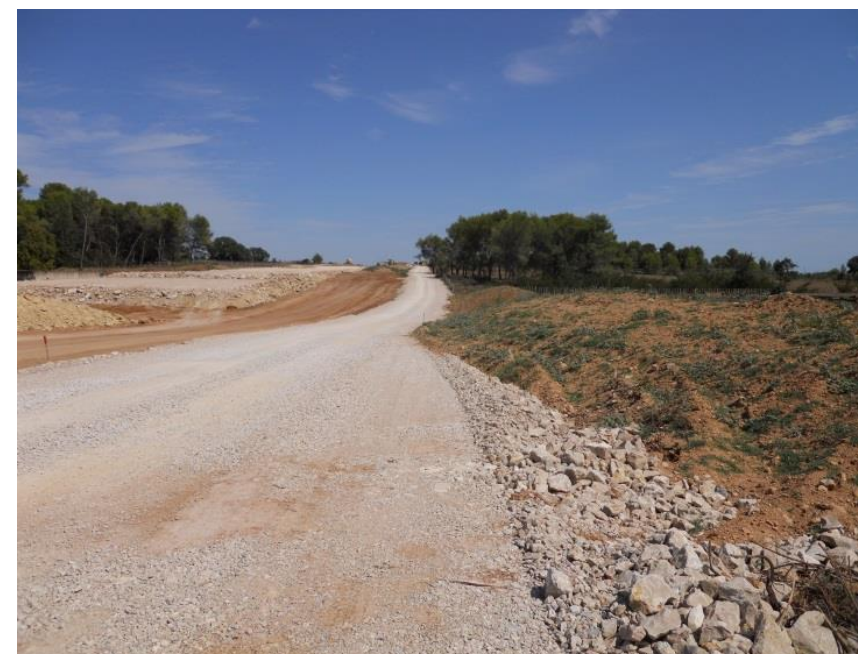
Photo 2 : Piste de chantier (Source : chantier CNM, setec)
