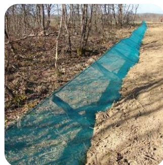
Illustrations de dispositifs de barrière anti-retour aux amphibiens le long d'habitats de reproduction (Source : Biotope)
