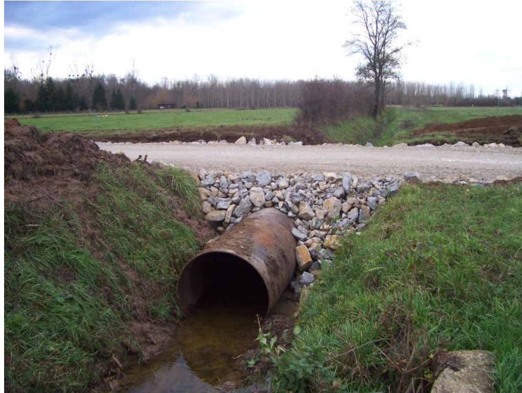
Photo 11 : Ouvrage hydraulique provisoire sous la piste de chantier (Source : chantier LGV Rhin-Rhône, setec)
