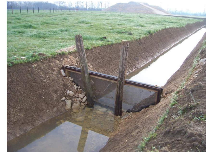
Photo 12 : Mise en place d'un filtre dans un fossé longitudinal (Source : chantier LGV Rhin-Rhône, setec)
