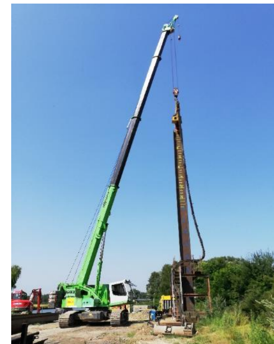
Photo 22 : Activité de vibrofonçage de palplanche (Source AcousTB, 2021)
