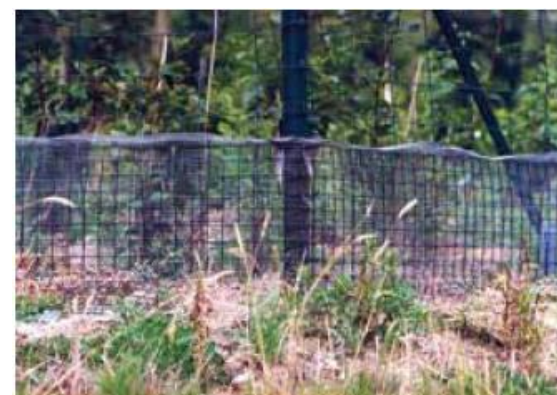
Treillis soudé à mailles fines adossé à une clôture à grandes mailles, avec la partie supérieure recourbée et la partie inférieure enterrée (Source : J. Carsignol, SETRA 2008)
