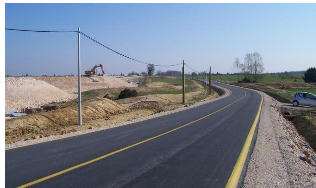
Photo 16 : Mise en place dérivation de route (Source : chantier LGV Rhin-Rhône, setec)
