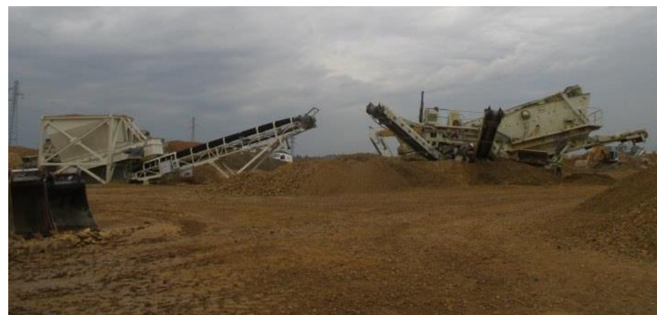
Photo 17 : Unité de criblage-concassage (Source : chantier CNM, setec)
