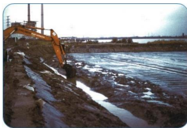
Figure 12 : Assèchement des matériaux de dragage (Source illustration : AVP – TEAM'O+, 2018)
