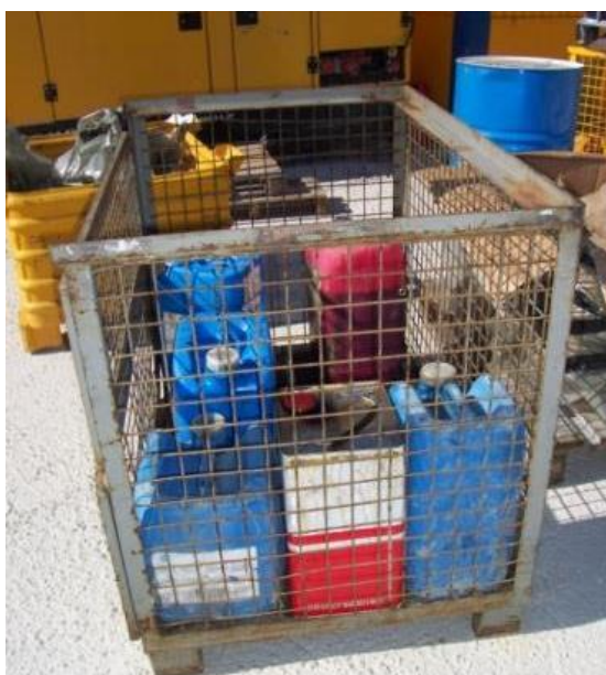
Photo 10 : Stockage de produits polluants sur une plate-forme étanche (Source : chantier LGV Rhin-Rhône, setec)
