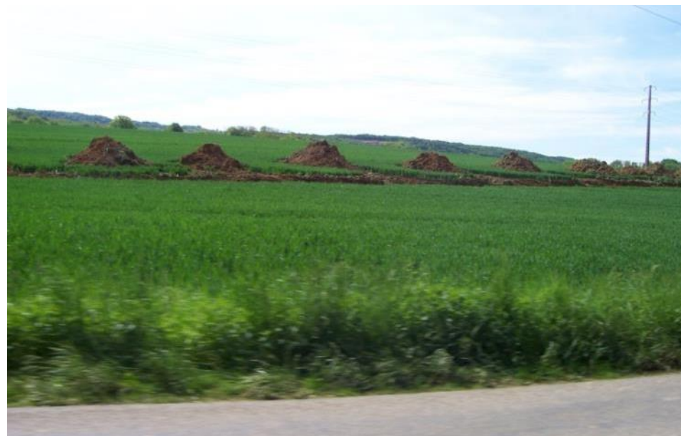
Photo 1 : Déviation de réseau (Source : chantier LGV Rhin-Rhône, setec)
