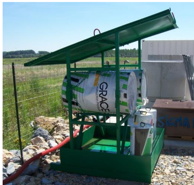
Photo 13 : Stockage de produits polluants à l'abri de la pluie (Source : chantier LGV Rhin-Rhône, setec)
