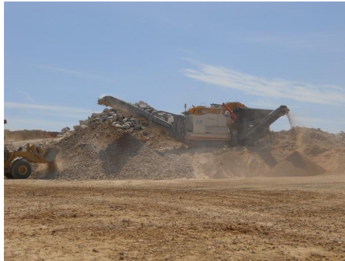
Photo 19 : Opération de criblage-concassage (Source : chantier CNM, setec)
