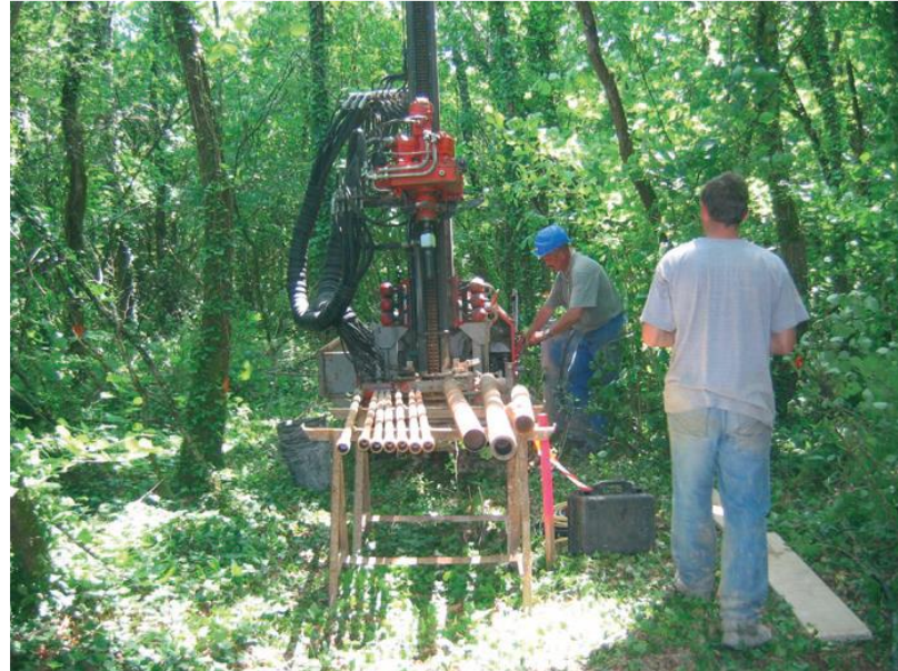
Exemple sondage géotechnique carotté- vue n°1 (Source : setec)
