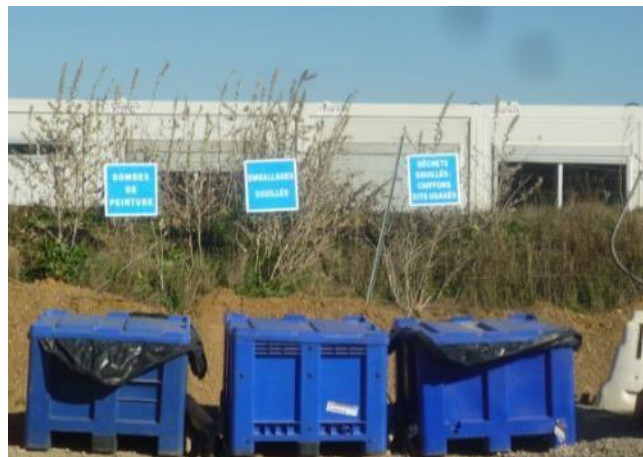
Photo 21 : Mise en place d'un tri des déchets (Source : chantier élargissement A9, setec)
