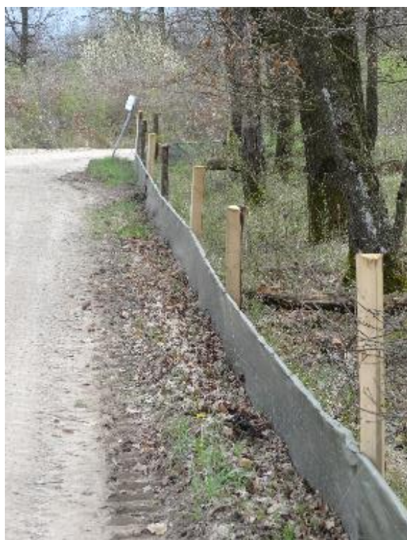
Figure 15 : Illustrations de clôtures provisoires (Source : Egis Environnement)
