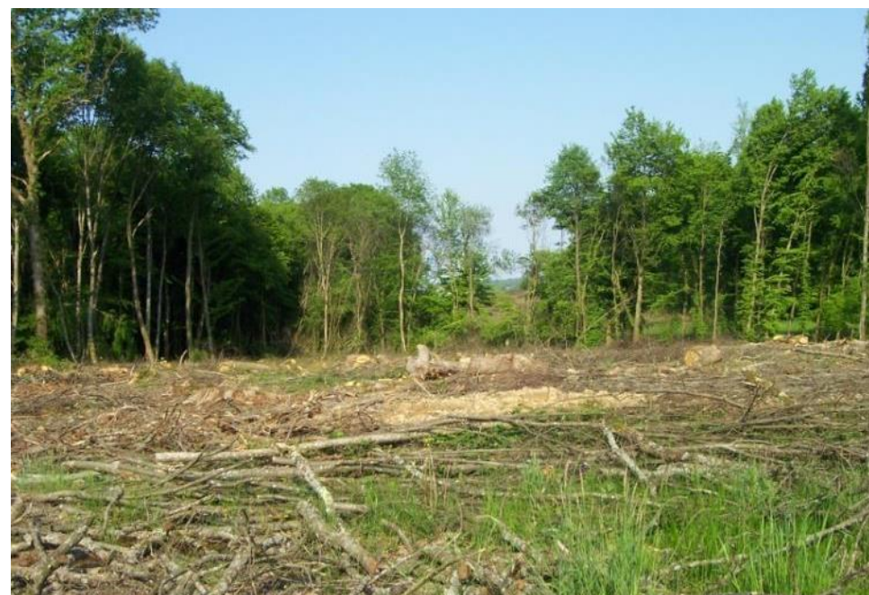
Photo 15 : Exemple de défrichement (Source : chantier LGV Rhin-Rhône, setec)
