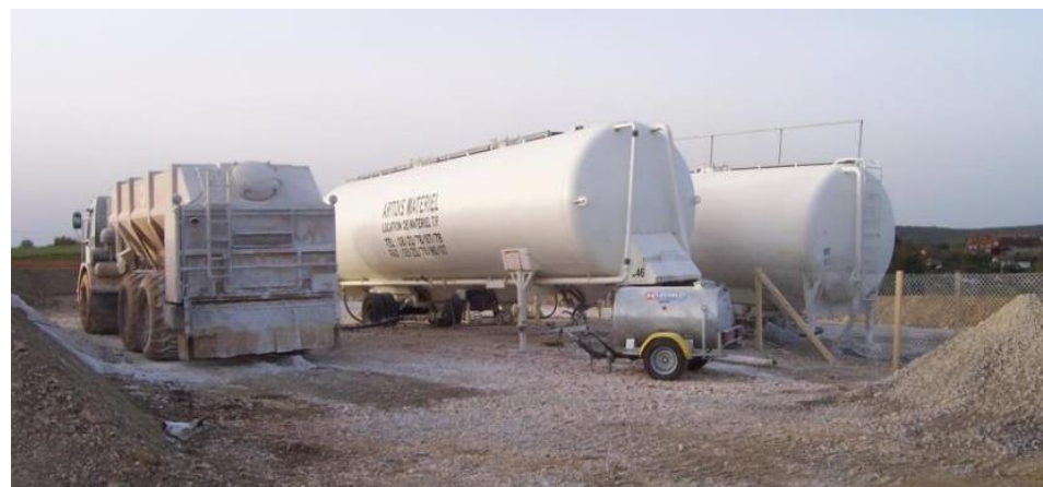
Photo 20 : Citerne de distribution de chaux pour le traitement des sols (Source : chantier LGV Rhin-Rhône, setec)
