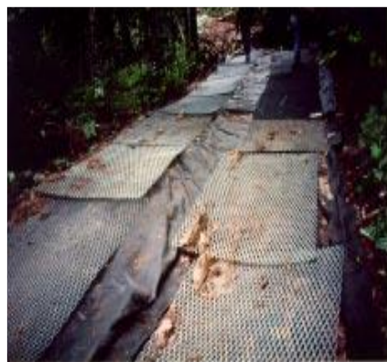
Plats-bords en zone humide (bois à droite et géotextile + géogrille) (Source : Biotope)
