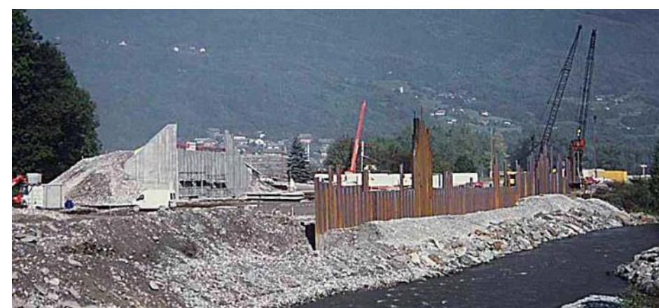
Photo 6 : Battage de palplanches (Source setec)
