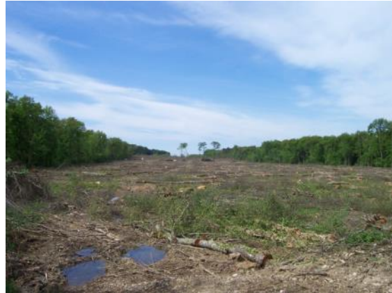
Photo 3 : Travaux de défrichage (Source : chantier LGV Rhin-Rhône, setec)
