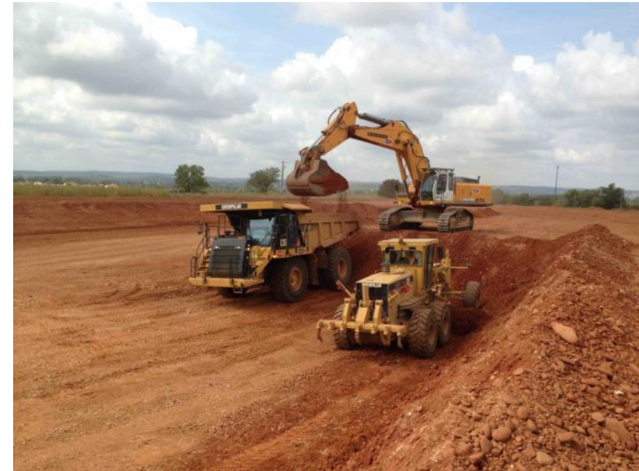
Photo 5 : Opération de terrassement (Source : chantier CNM, setec)
