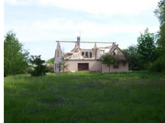
Photo 4 : Démolition de bâti (Source : chantier LGV Rhin-Rhône, setec)
