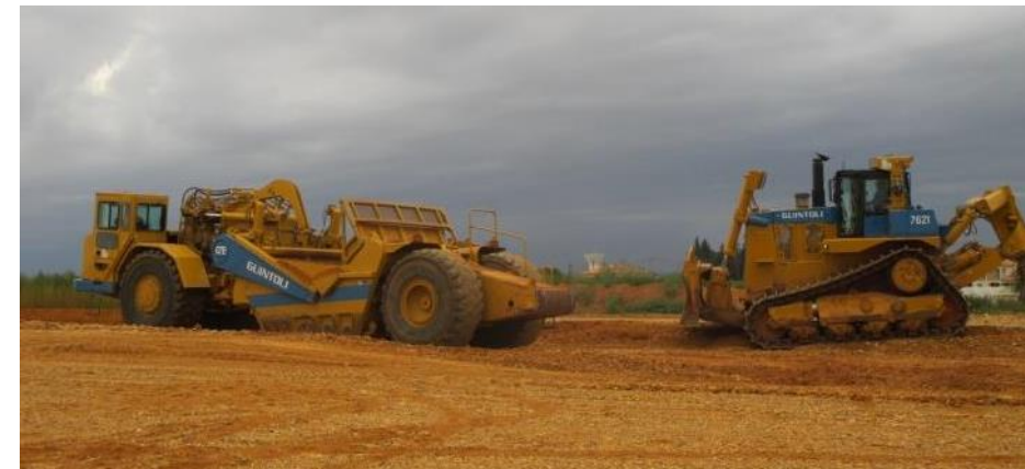
Photo 18 : Engins de chantier (source : chantier CNM, setec)
