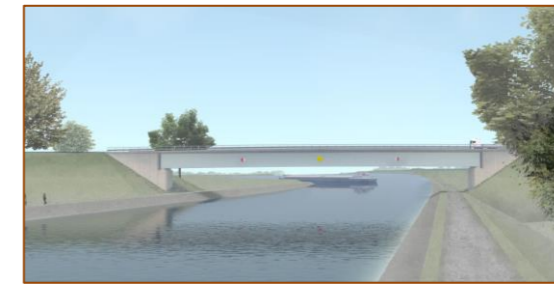
Ouvrages de type Bipoutre
