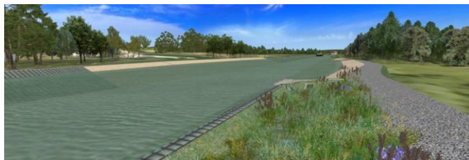
Exemple de pentes douces sur le Canal Seine-Nord Europe
