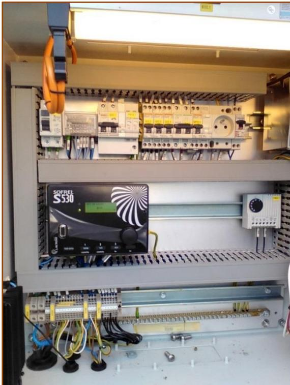
Ce capteur hauteur / vitesse (doppler) (matériel VNF) est connecté à une centrale Meanstream 3 (marque Hydréka). Les données sont transmises par une liaison filaire vers un sofrel S530 (marque Lacroix sofrel).
