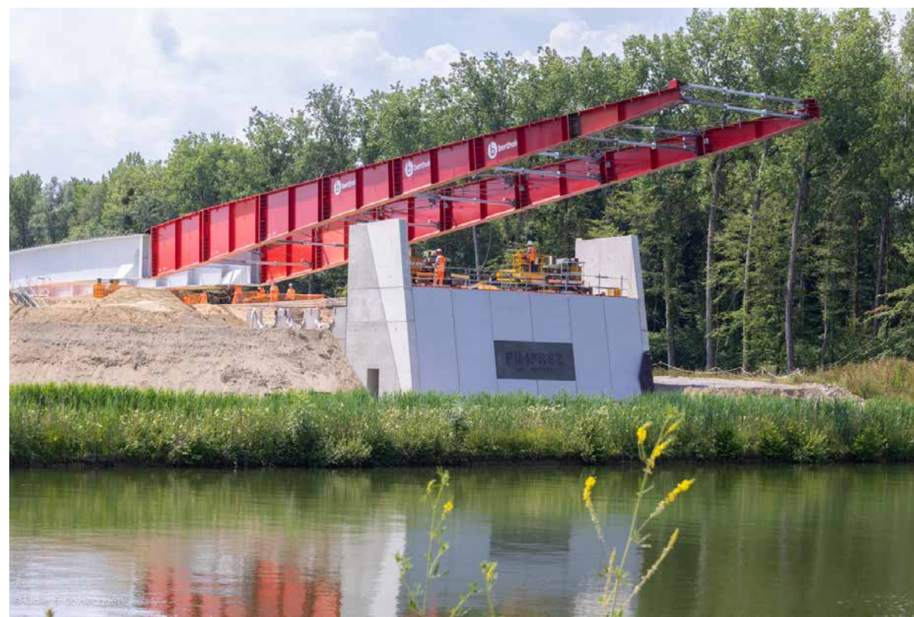
Pose des dalles en béton armé sur la charpente métallique en place pour former le tablier du pont de la RD 40 bis à Pimprez, juillet 2024.
