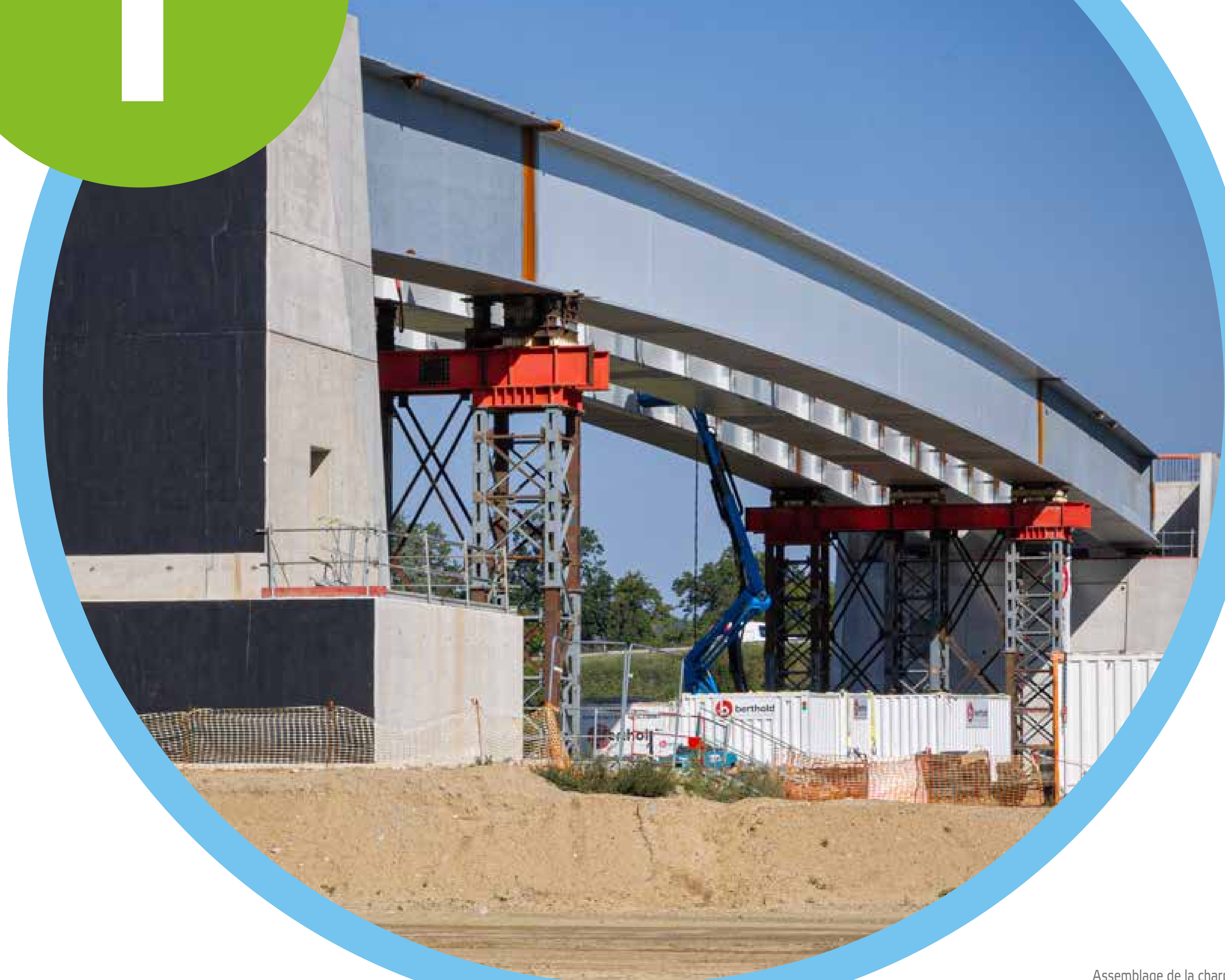
Assemblage de la charpente du pont de la RD 66 sur le futur Canal Seine-Nord Europe, septembre 2023.
