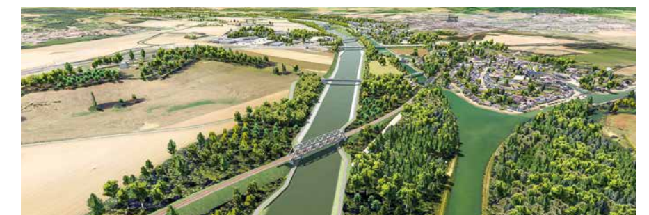
Pont ferroviaire à Pont-L'Évêque © SCSNE / Pixxim
