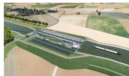
Écluse de Catigny © SCSNE / Pixxim
