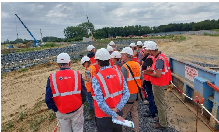
Visite du chantier sur le secteur 1 – rescindement de l'Oise
