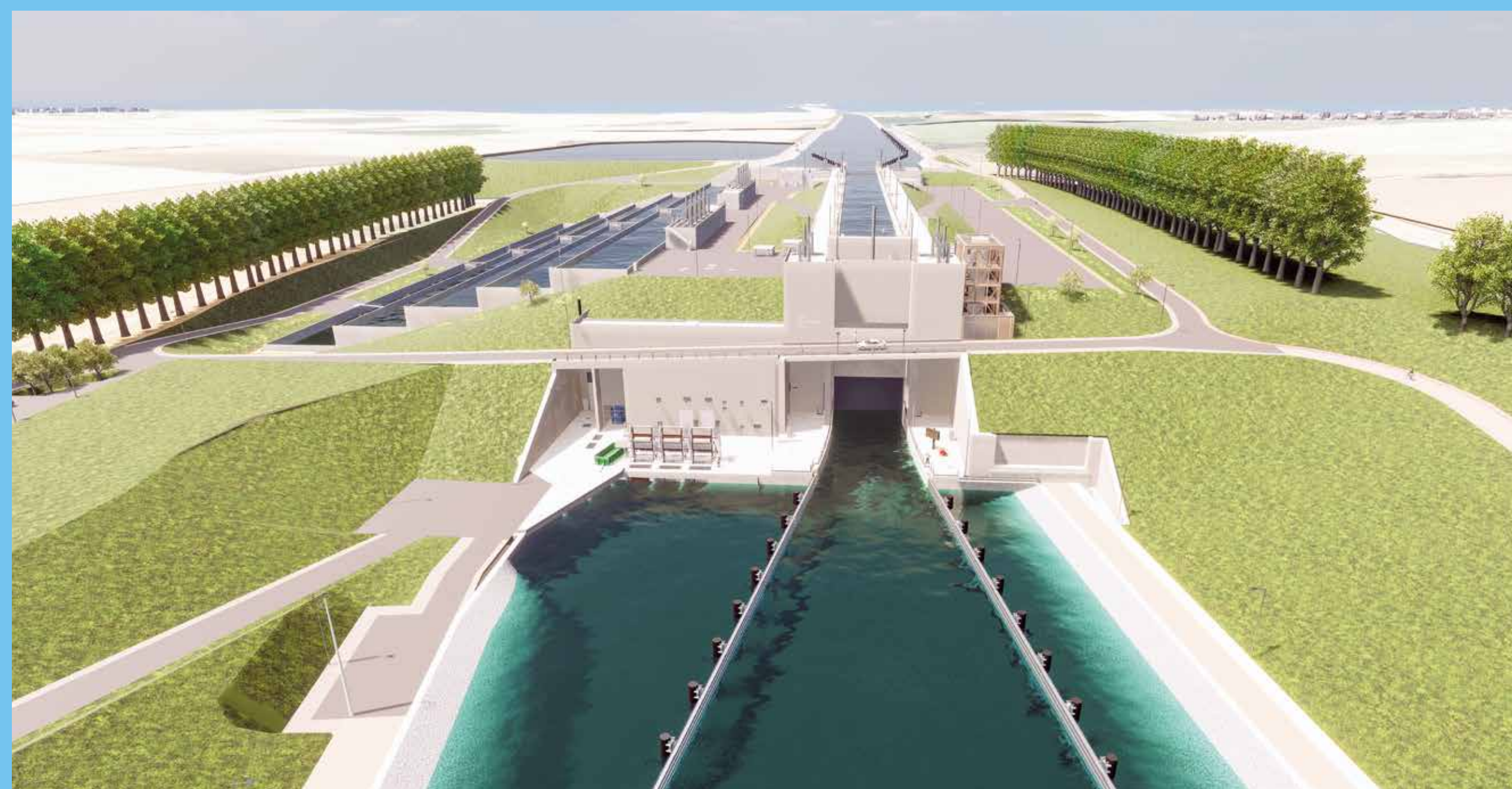
Recyclage de l'eau aux écluses grâce à des bassins accolés au sas (à gauche sur l'image)
