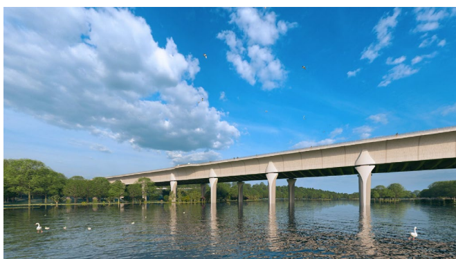
Le Pont-Canal de la Somme dans la traversée du bras en eau de la Somme
