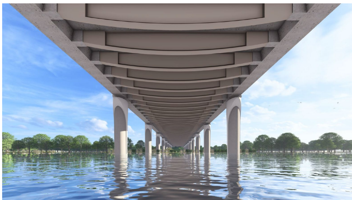
La sous-face du tablier et l'enfilade des piles © Canalieau / Lavigne Chéron architectes
