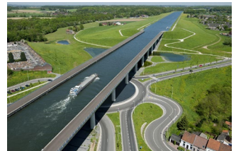
Pont-canal du Sart (Belgique)
