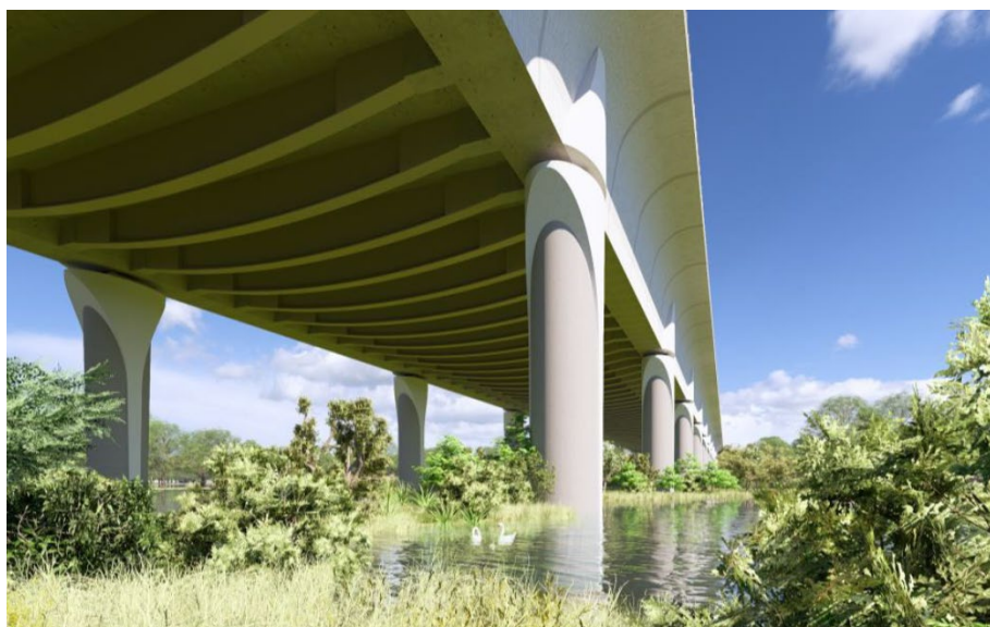
La sous-face du tablier et les entretoises © Canalieau / Lavigne Chéron architectes
