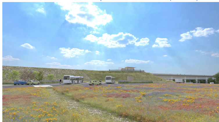
Culée Nord : stationnement à proximité de la voie UNEAL (vue basse)
