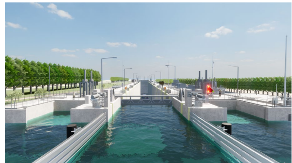
Porte amont fermée @ONE5-SCSNE
