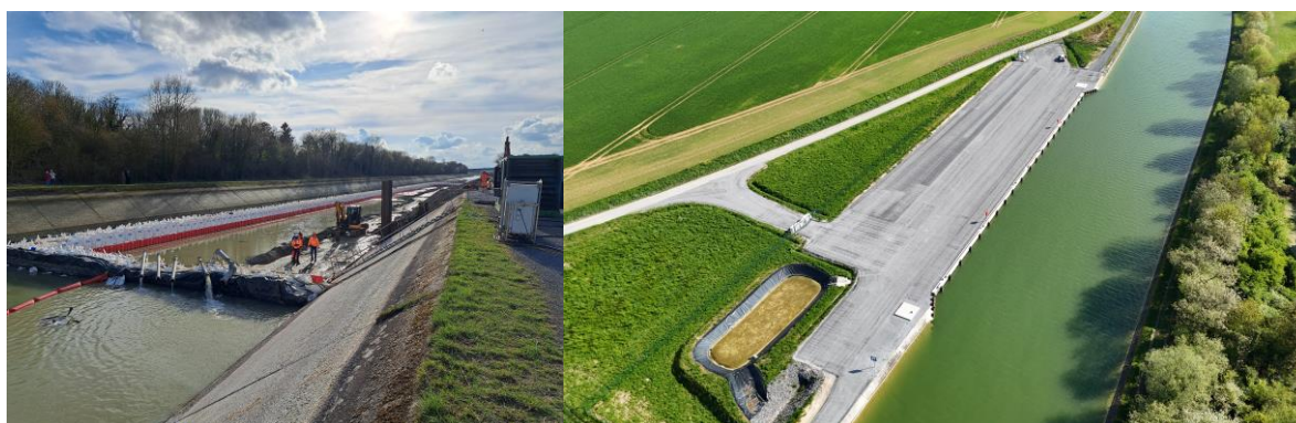
Figure 60 : Travaux du quai d’Allaines avec chômage du Canal du Nord (à gauche) et vue aérienne du quai d’Allaines finalisé (à droite) (source : SCSNE, 2026)
