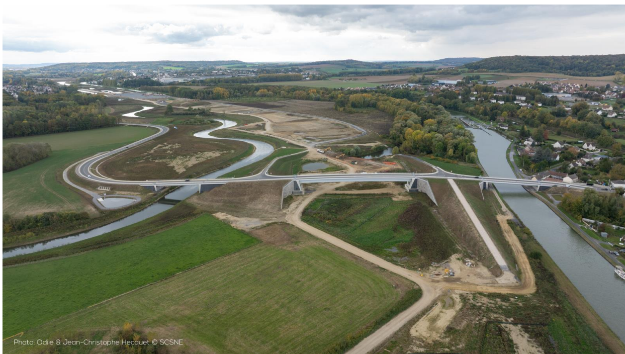
Figure 57 : Ponts de rétablissement de la RD66 finalisés au niveau du rescindement de l'Oise (source : Odile & Jean-Christophe Hecquet, 2026)
