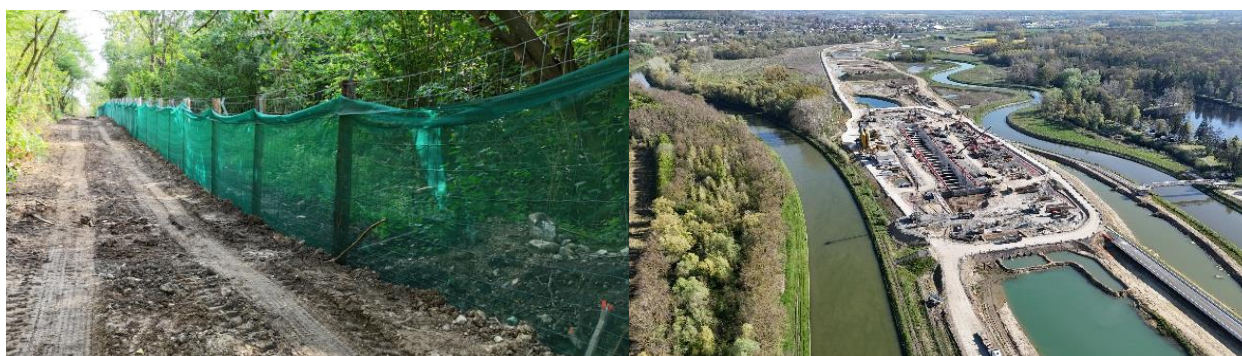
Figure 58 : Exemple de barrières petite faune (à gauche) et vue d'ensemble du chantier de l'écluse (à droite) (source : SCSNE, 2026)
