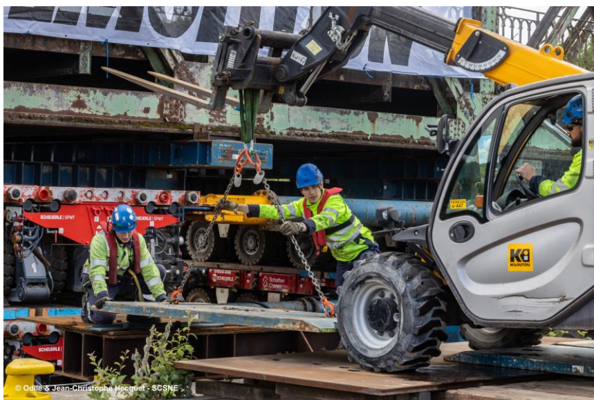
Figure 11 : Photo de compagnons en action lors du chantier de démolition par barge du pont de la RD40 au niveau de Ribécourt-Dreslincourt (source : Odile & Jean-Christophe Hecquet, 2026)
