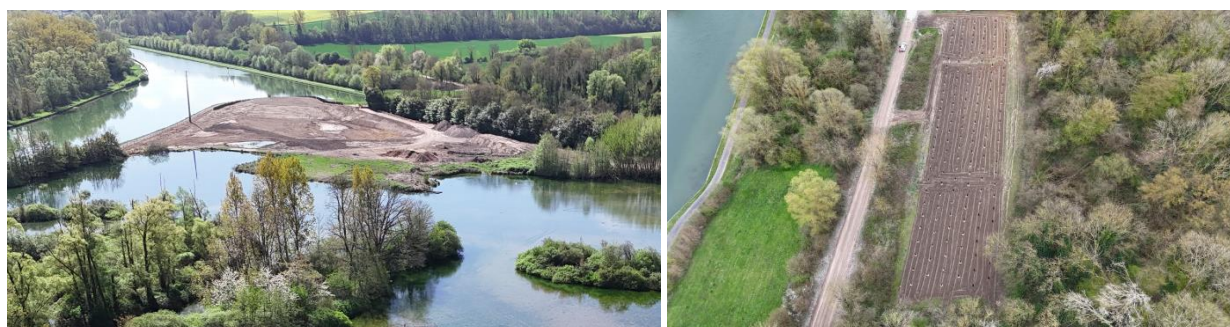
Figure 13 : Illustration de travaux de génie écologique (réhabilitation de zones humides à gauche et plantations à droite) réalisés au sein de la vallée de la Somme (source : SCSNE, 2026)
