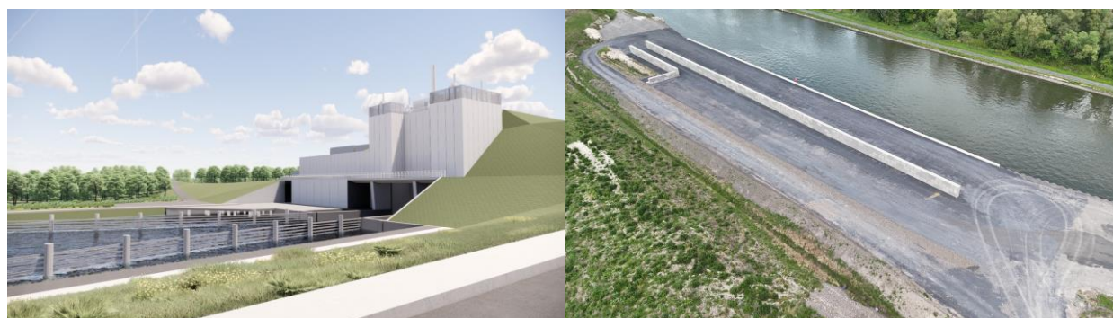
Figure 62 : Photomontage de la future écluse d'Oisy-le-Verger (à gauche) et vue aérienne du quai d'Aubencheul-au-Bac finalisé (à droite) (source : SCSNE, 2023 et 2026)
