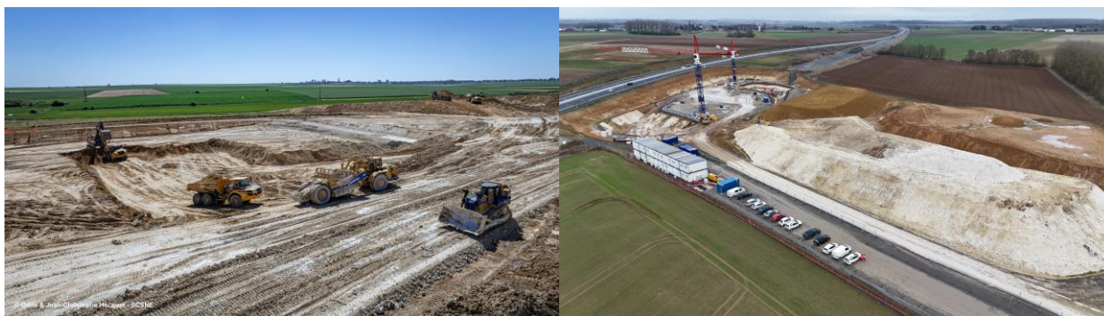
Figure 61 : Travaux de la fouille d'Oisy-le-Verger (à gauche) et travaux du futur viaduc de l'A2 (à droite) (source : Odile & Jean-Christophe Hecquet et SCSNE, 2026)
