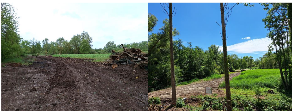
Figure 12 : Illustration de travaux de génie écologique (restauration de roselières) réalisés au sein de la vallée de l’Omignon (source : SCSNE, 2026)
