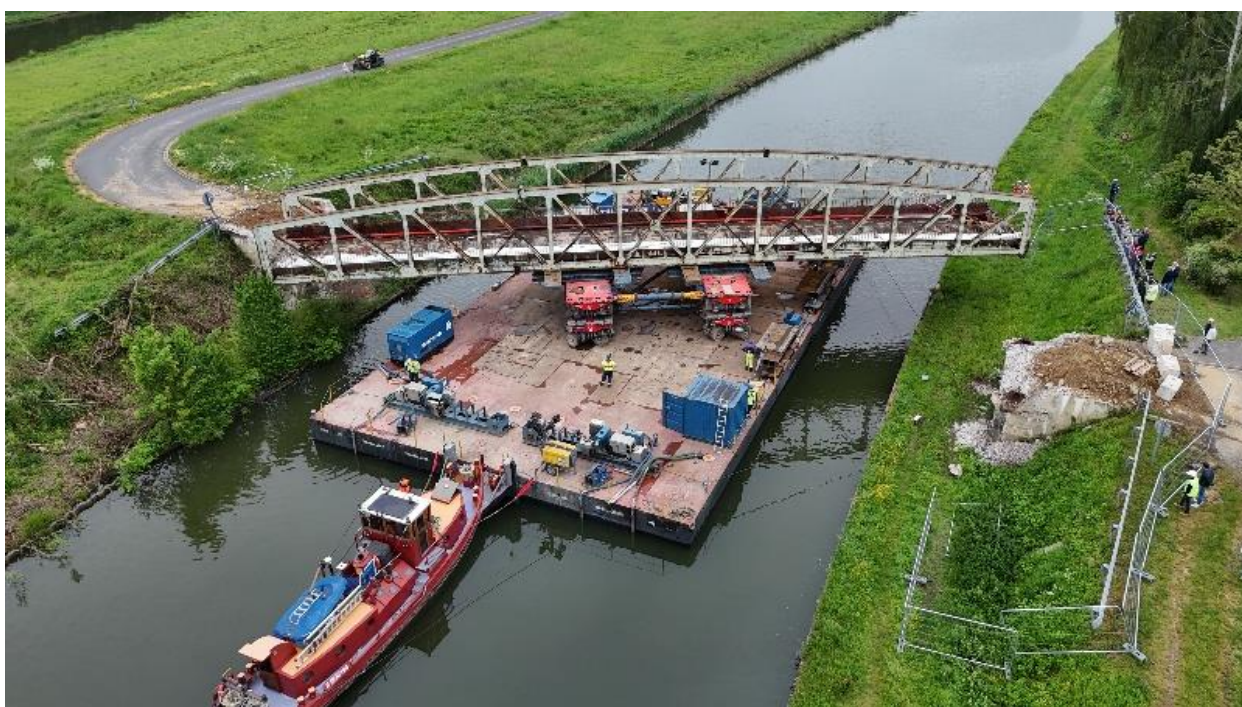
Figure 59 : Dépose du pont de la RD608 par barge (source : SCSNE, 2026)
