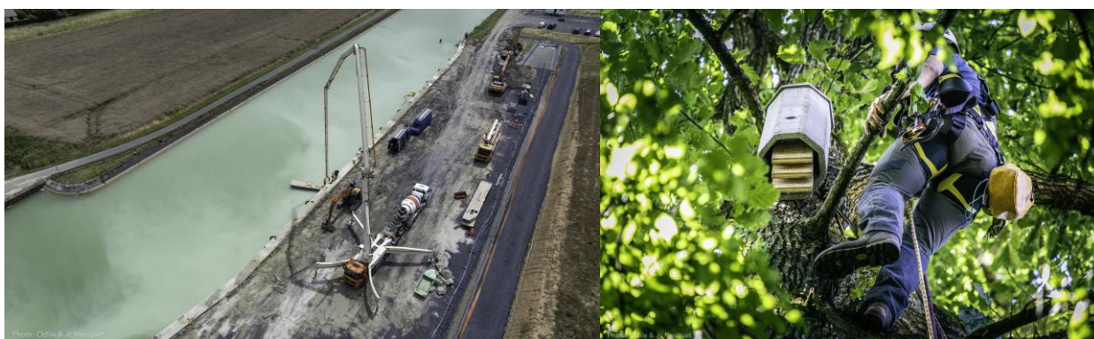
Figure 60 : Vue aérienne du quai travaux de Noyon en cours de réalisation (à gauche) et pose de gîtes à chiroptère au niveau du secteur 2 (source : Odile & Jean-Christophe Hecquet, 2026)
